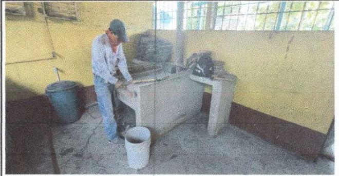
Foto 8: Mantenimiento a estufa rural. Sustitución de plancha de metal de 3 hornillas en área de cocina.
