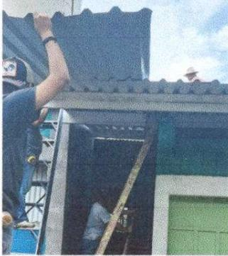
Foto1: Sustitución de lámina por lámina troquelada aluzinc calibre 26. Sustitución de elementos de fijación en corredor del módulo 6.
