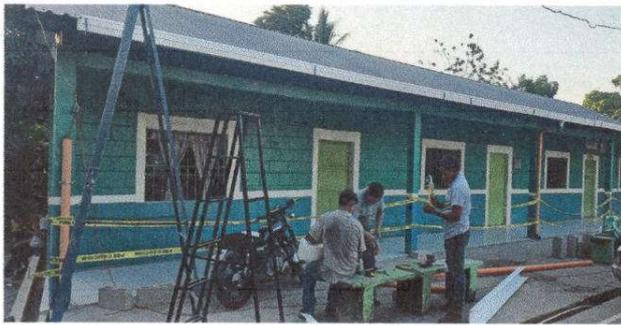
Foto 5: Sustitución de canales de PVC. Reparación de bajadas de agua pluvial. Sustitución de soportes o pescantes de metal para canal en todo el establecimiento.
