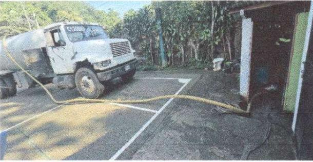
Foto 7: Reparación de red de drenaje y red de agua potable. Limpieza de fosa séptica.
