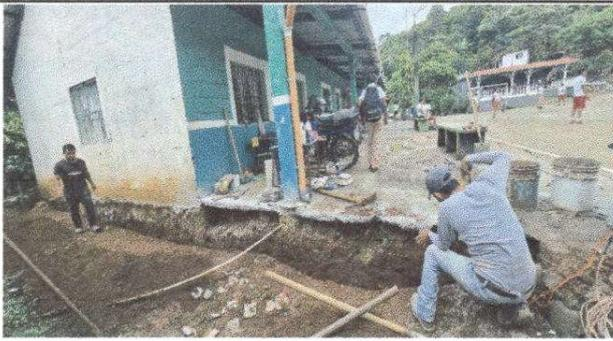
Foto 9: Reparación de cuneta de concreto
