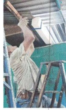
Foto 2: Estructura de techo. Sustitución de soportes de madera por metal en pasillo de módulo 5.
