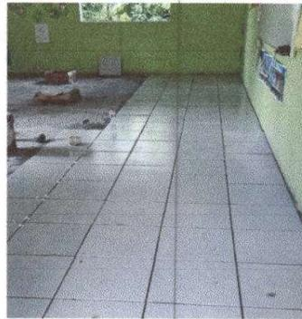
Foto 4: Sustitución de piso torta de cemento líquido por piso cerámico en todo el establecimiento.
